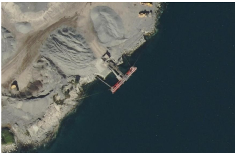
Figur 10. Utskipingskai ved steinbruddet
