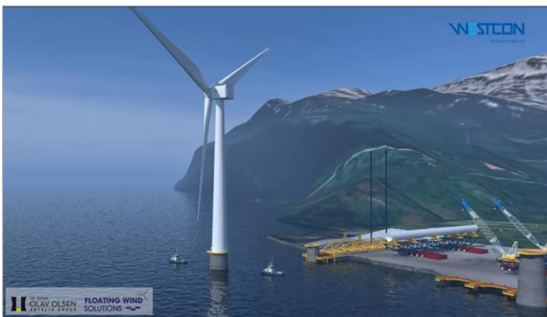
Figur 1-3 Illustrasjon fra Westcon. Ferdigmontert vindturbin i sjø, og slep av denne.
