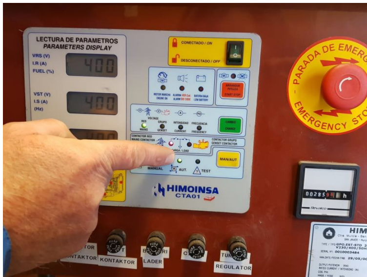
Bilde 1: Viser grønt lys for automatisk drift
