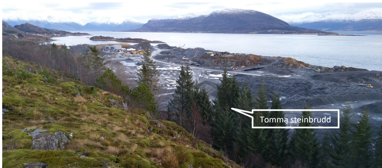
Eksisterende brudd sett fra Høgkleppen, mot nordøst
