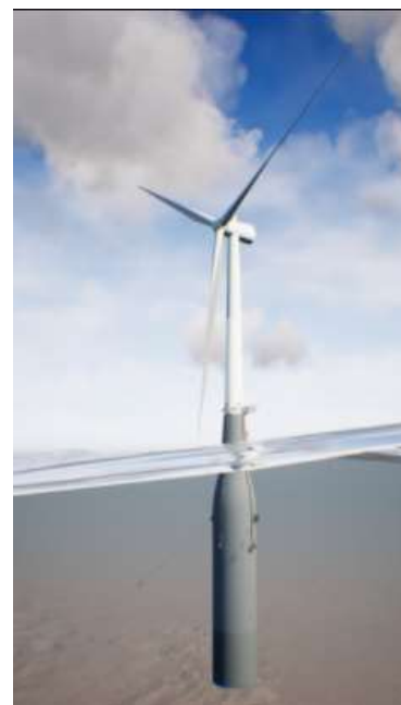
Figur 9 Illustrasjon som viser en ferdig montert vindturbin på flytende betongfundament. Kilde Aker solutions
