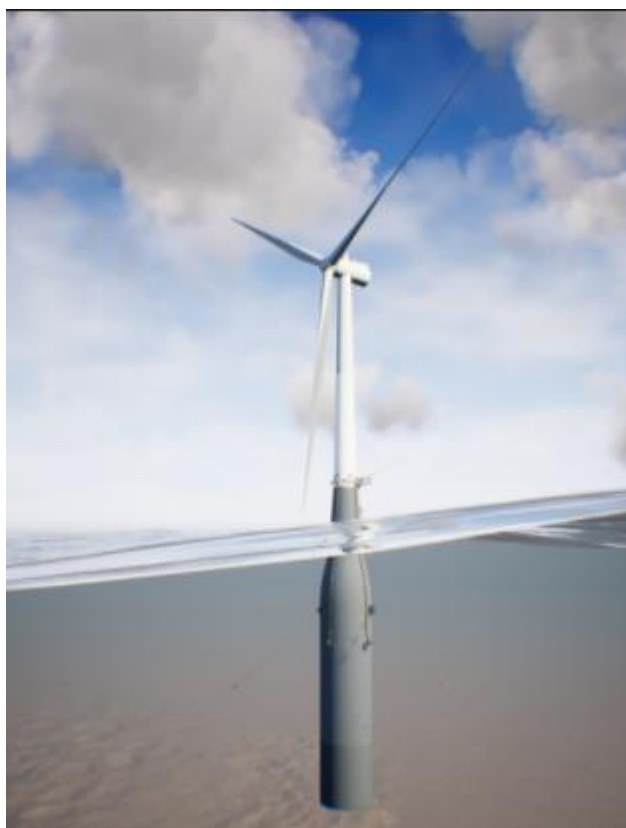
Figur 1-2 Illustrasjon som viser en ferdig montert vindturbin på flytende betongfundament. Kilde Aker solutions
