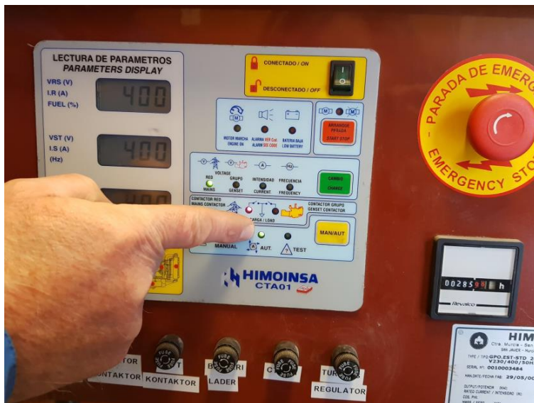
Bilde 1: Viser grønt lys for automatisk drift
