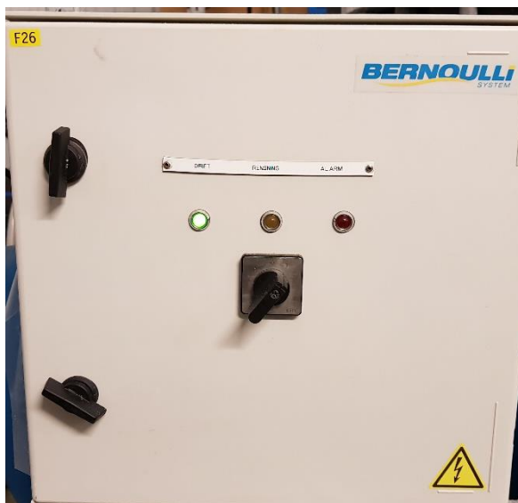
Bilde 2: Betjeningspanel Bernoulli-filter skal være grønt
