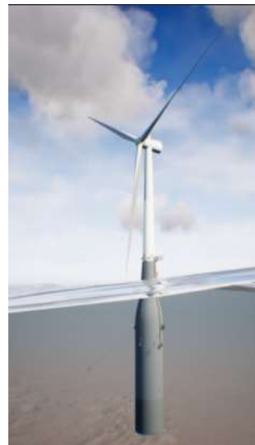
Figur 9 Illustrasjon som viser en ferdig monteret vindturbin på flytende betongfundament. Kilde Aker solutions
