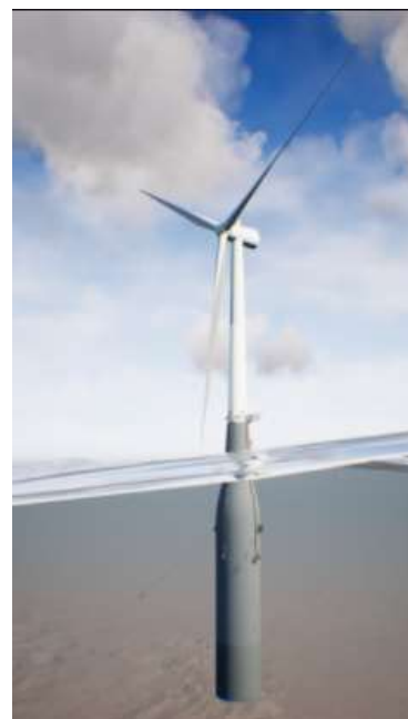
Figur 7 Illustrasjon som viser en ferdig montert vindturbin på flytende betongfundament. Kilde Aker solutions
