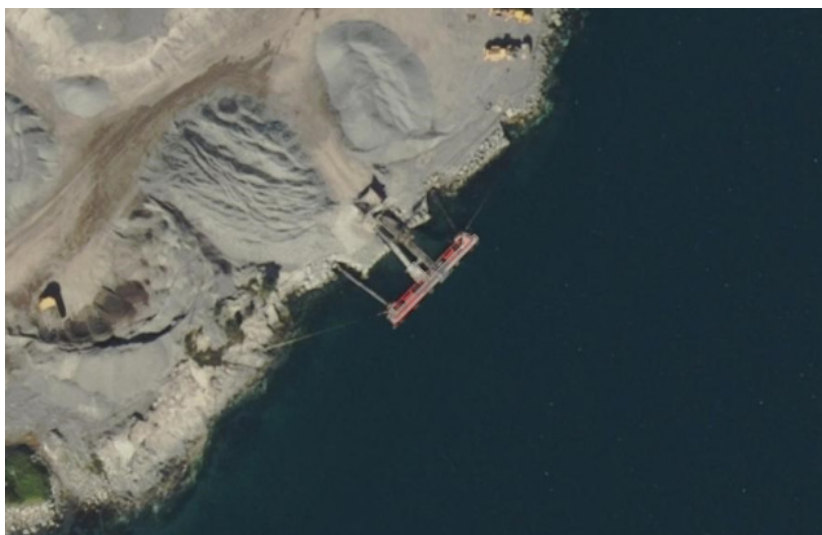
Figur 10. Utskipingskai ved steinbruddet
